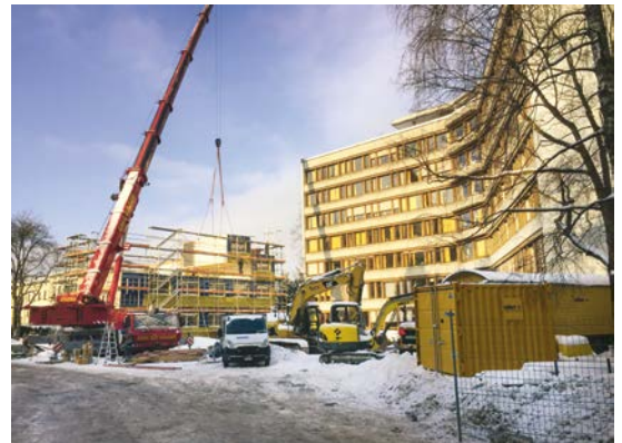
GERIATRISCHE KLINIK Bevor die Umbauarbeiten im Hauptbau starten können, wird ein Provisorium erstellt.
